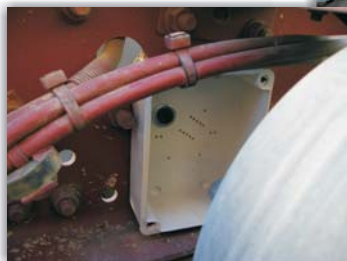
Instalación caja sensores
